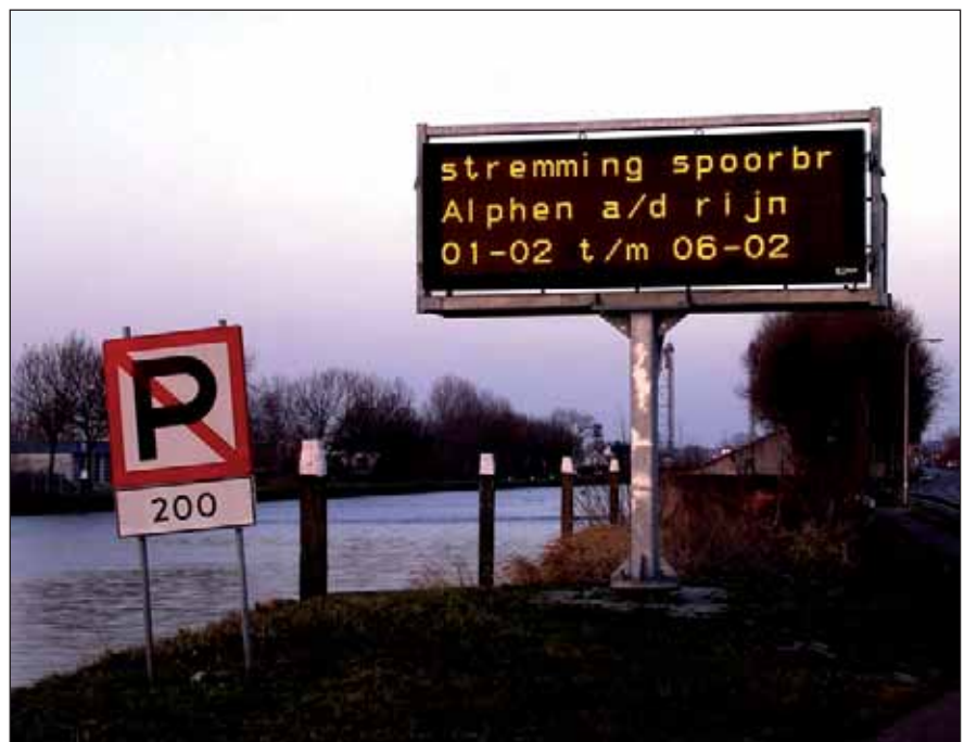
Figuur 11: Dynamisch Route Informatie Paneel (DRIP) bij Alphen
